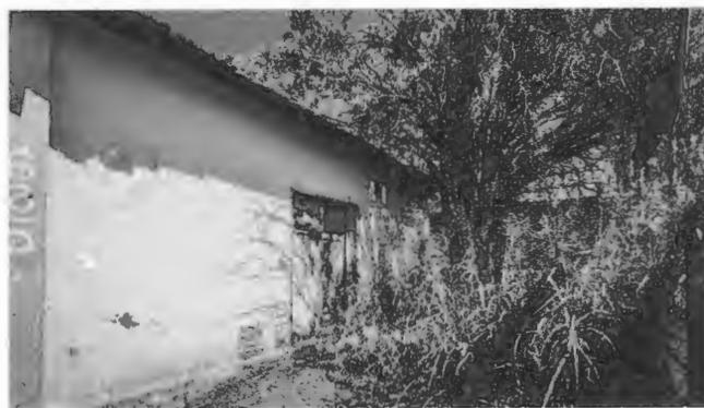
Ao vistoriar o local, constatamos que o forro de madeira da sala principal desabou em algumas partes, por onde entra a água da chuva, pois o telhado também está comprometido. O reboco das paredes caiu e há grandes rachaduras. A parede de um dos banheiros foi derrubada, permitindo o acesso pelo quintal.
